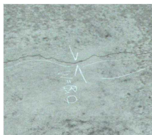
ひび割れ幅 W=3.0mm
