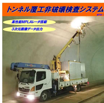
トンネル覆工内部調査 (レーダ計測)
