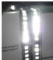
LED照明点灯状況
