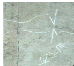
ひび割れ幅 W=0.25mm
