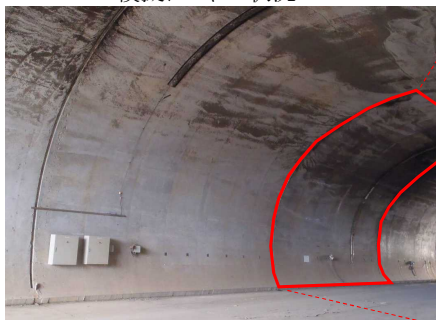
模擬トンネル状況
