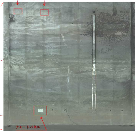
ひび割れ幅チョーキング箇所
