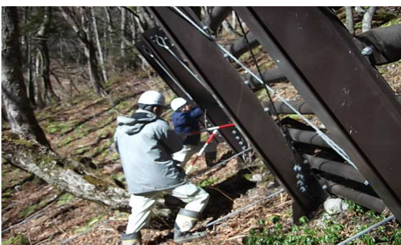
雪崩防止施設点検(長野県)
