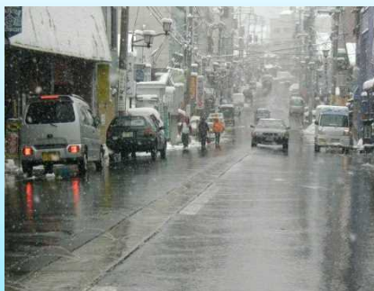
下水処理水を活用した消雪
