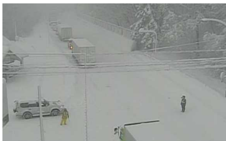
通行止めの状況
