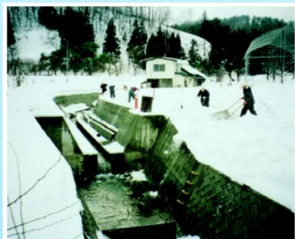
除排雪低水路(山形県村山市)
