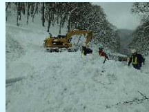
雪崩発生箇所の現地調査
