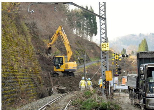
片切掘削状況
