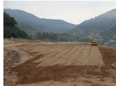
自律制御による転圧作業状況
