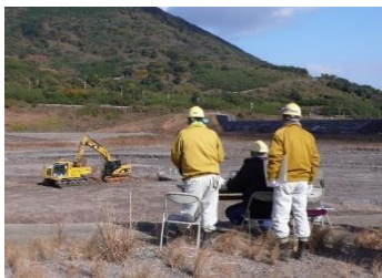
掘削積込検証(目視)状況
