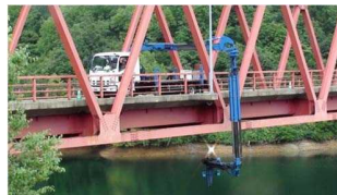
橋梁下面点検
