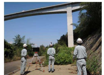
作業状況全景
