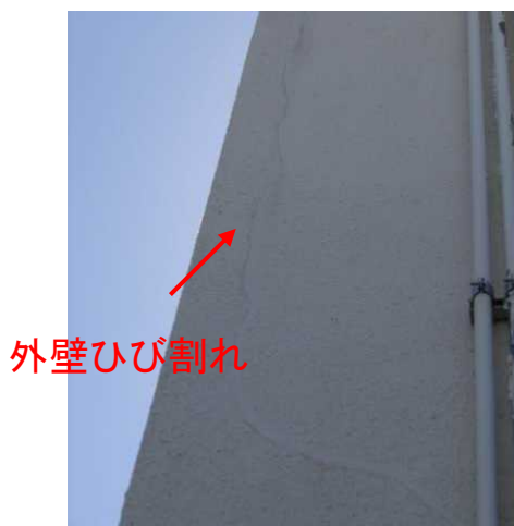
外壁：外壁にひび割れが発生
