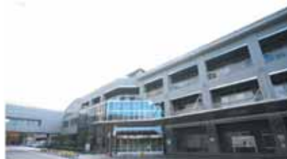
横浜ラポール (14,421 m 2 , 1991 年竣工)
