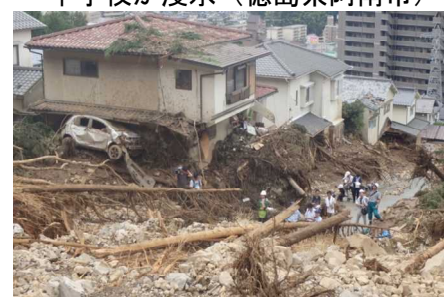
土砂災害による甚大な被害 （広島県広島市）
