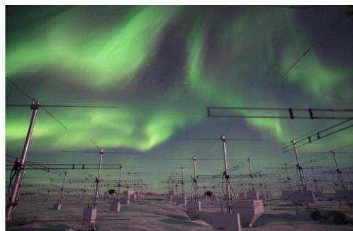
**南極昭和基地に建設した大型大気レーダー**：アンテナ素子に航空機用アルミ合金を使用。共振を排除する空力構造設計と風洞および現地試験の繰り返しにより、超軽量かつ十分な耐候性を得た。
