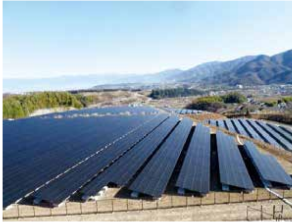
図表2-6-22 米倉山太陽光発電所
