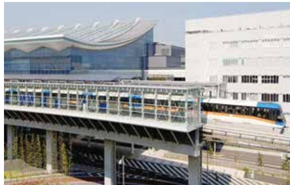
東京モノレール線羽田空港国際 線ビル駅
