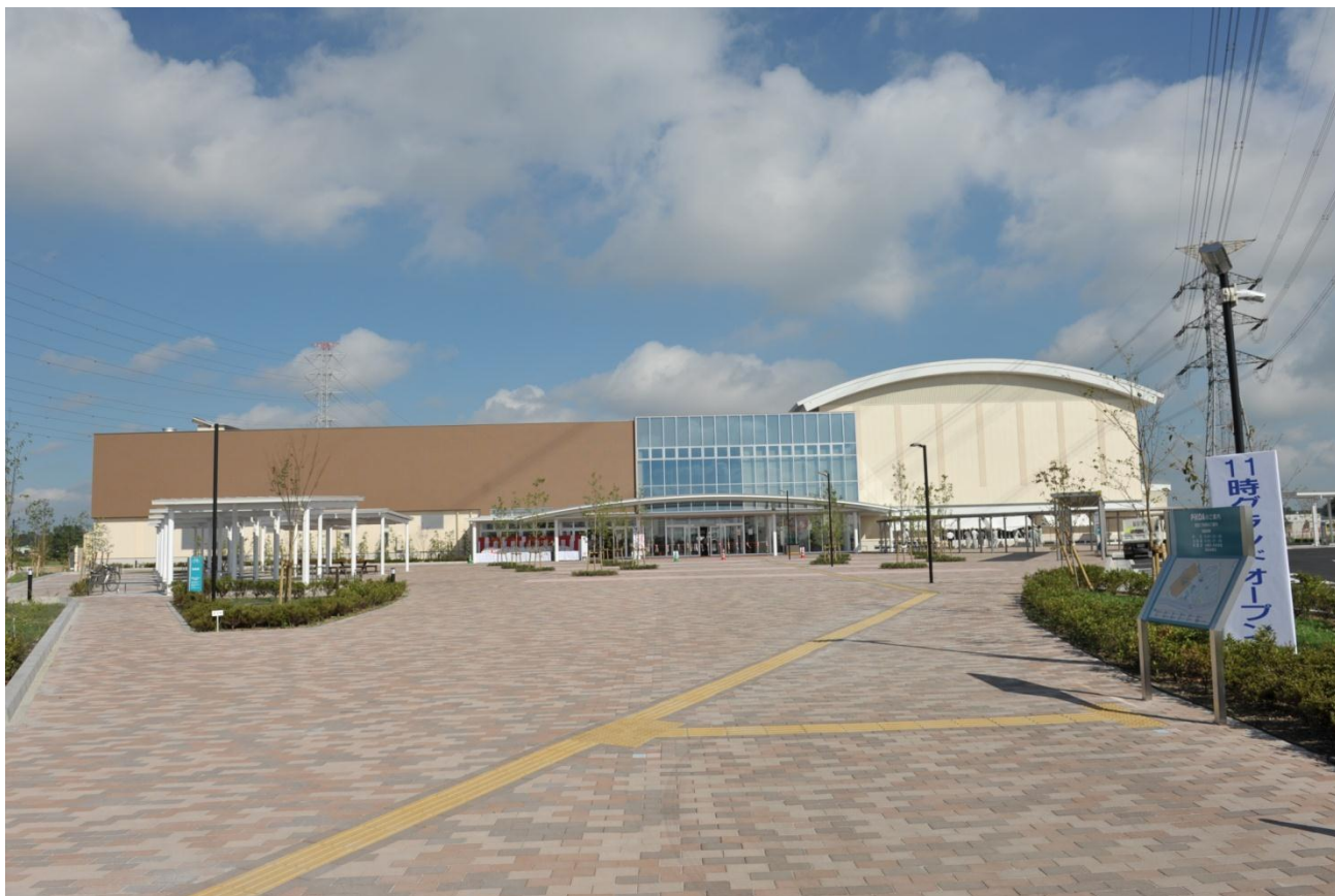
温水利用型健康運動施設全景写真
