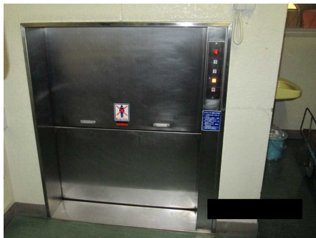
事故 I 事故機の出し入れ口
