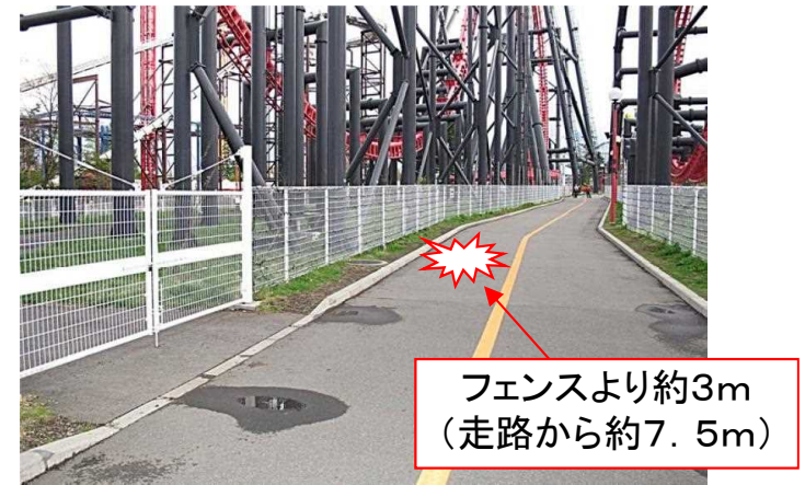
写真1. ボルト落下場所
