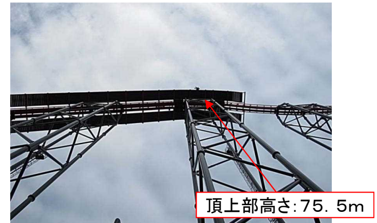
写真2. ボルト落下推定位置より上方視
