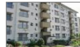
エレベーターのない中層団地
