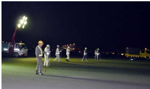
写真一 点検方法（打音調査）
