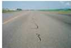
写真4.1.1 ひび割れ充填後の状況
