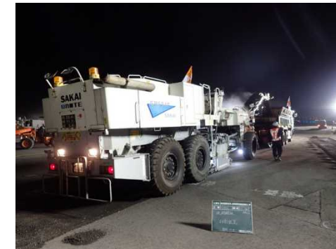
写真三 切削オーバーレイ工
