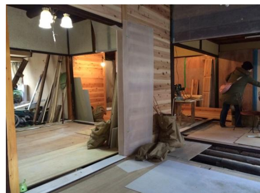
写真 3-2-5 内装改修の様子
