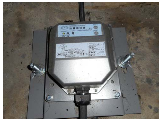
写真：地震時管制運転装置(拡大)
