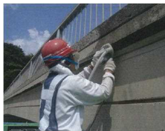
補修実施状況
