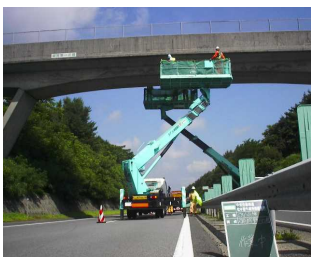
点検実施状況
