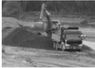
十勝川河道掘削
