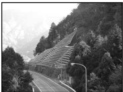
<斜面崩落防止対策>
