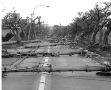
<電柱の倒壊による道路閉塞>
