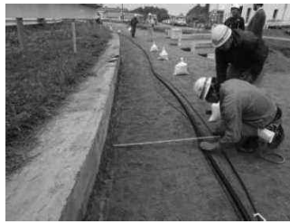
ケーブルを直接埋設している状況
