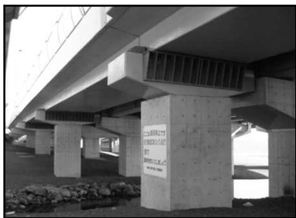
<橋梁の耐震補強>
