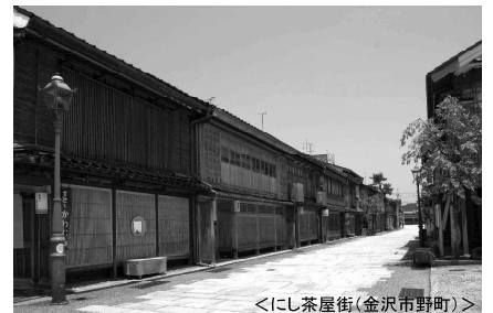
＜にし茶屋街(金沢市野町)＞ 歩道の無い道路の無電柱化
