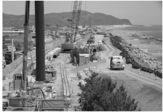
海岸堤防の耐震・液状化対策（高知県土佐市）
