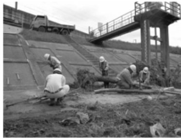
樋門吐口に堆積した塵芥の処理
