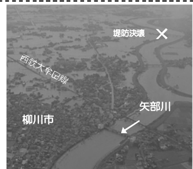
矢部川の被災状況（福岡県柳川市）
