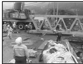
土石流で損傷した県道橋梁の仮設橋設置のための技術支援を実施
