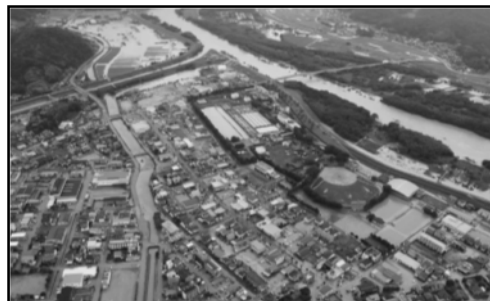
京都府 福知山市 由良川水系の氾濫状況
