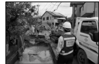
地元建設業と連携し市街地に堆積した土砂撤去を緊急的に実施
