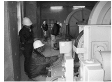
ダム放流設備点検状況
