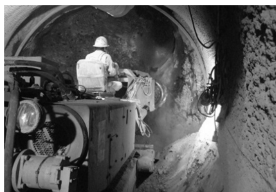
地下水排除のための排水トンネルの設置
