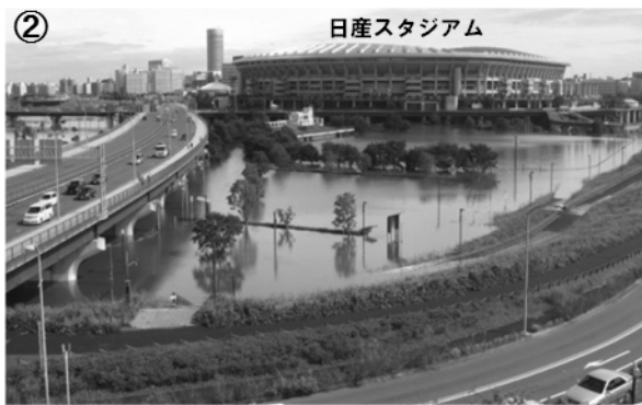
過去最大となる154万m 3 を貯留した鶴見川多目的遊水地
