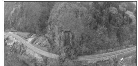
国道148号の土砂崩落状況（長野県）
