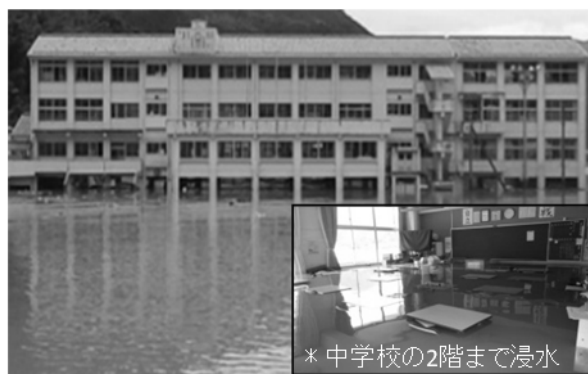
徳島県 阿南市 那賀川水系の浸水状況(台風 11 号) * 中学校の 2 階まで浸水
