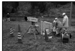
監視カメラ(6 台)を用いて被災箇所の 24 時間監視を実施
