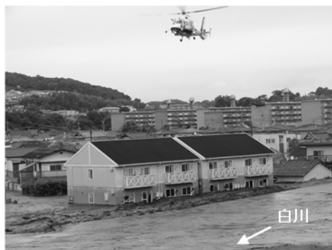
被災状況（熊本県熊本市）
