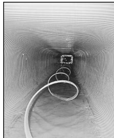
更生工法を施した管渠
