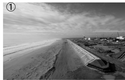
① 背後の南蒲生浄化センター復旧工事に先行して完成した仙海岸深沼地区の海岸堤防（H26.11）
