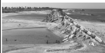
東日本大震災における堤防、水門の破壊
