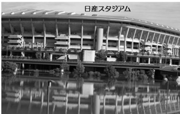
日産スタジアム付近の湛水状況
