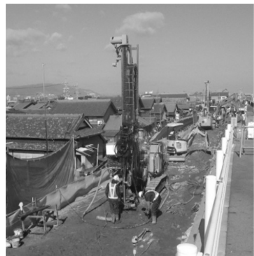
締固め工法による液状化対策（三重県桑名市）
