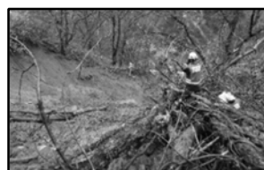
土石流危険渓流(76 渓流)において緊急点検による危険度評価等を実施
