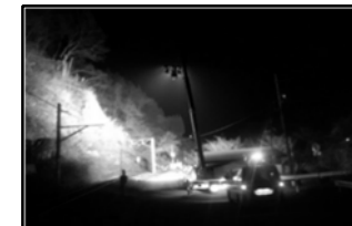
照明車を用いて夜間の被災状況調査を実施
