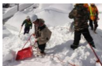
転落防止対策（命綱、アンカー）
