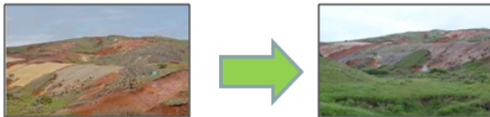
侵食防止シートの設置による植生回復
