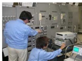
(航空保安施設点検実施状況)
