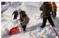
転落防止対策（命綱、アンカー）
