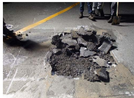
はつり作業後の状況
