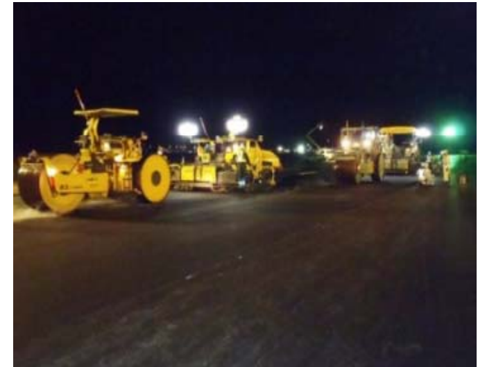
緊急補修実施
