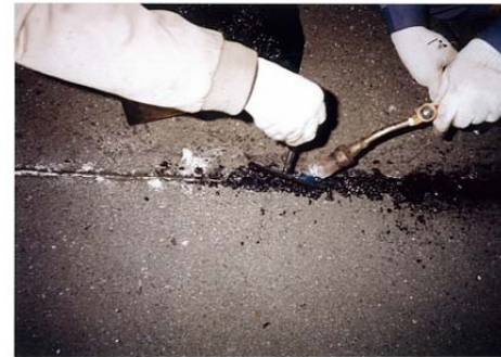
写3.1.1 ひび割れ充填
