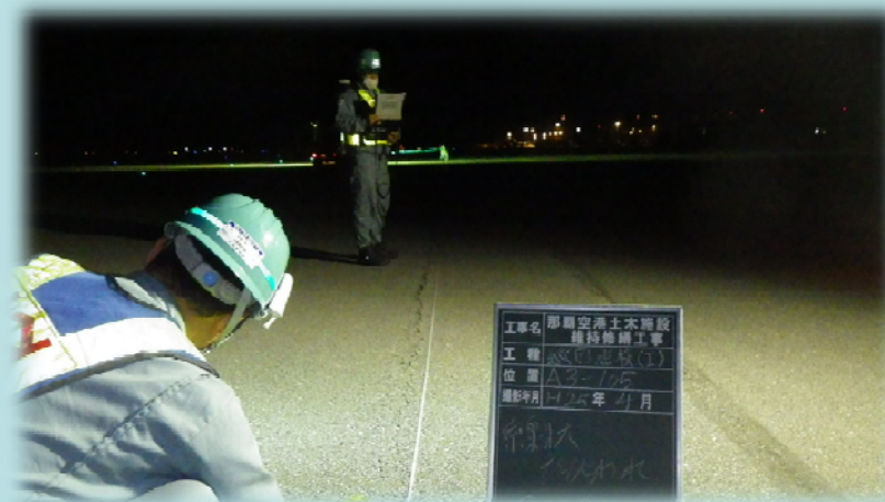
舗装異常個所の測定及び記録状況
