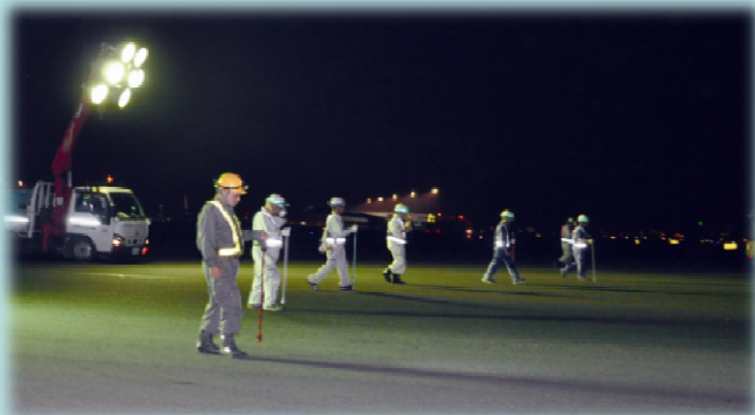
巡回点検作業(目視、打音点検)
