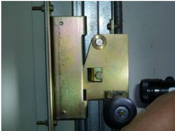
写真Ⅱ－8 2階の施錠装置
