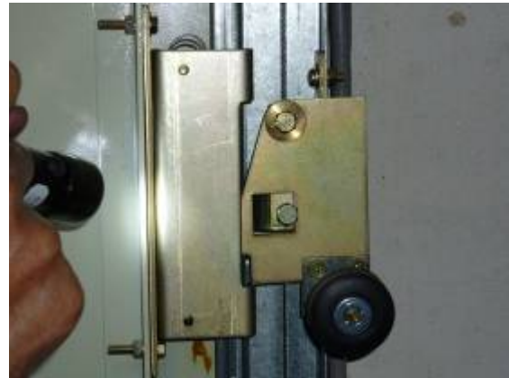
写真Ⅱ－9 3階の施錠装置
