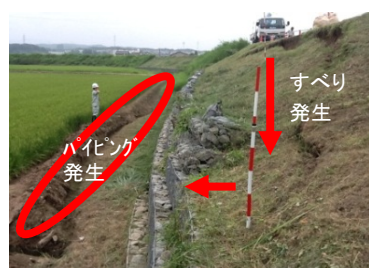
梯川の堤防被災と被災メカニズム(想定)
