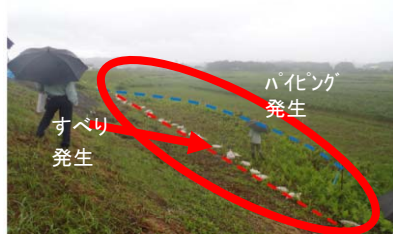
子吉川の堤防被災と被災メカニズム(想定)
