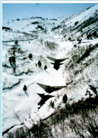
雪崩の発生危険箇所をもつ砂防えん堤(長野県白馬村)
