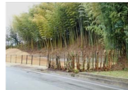
生コンプラント撤去後の状況
