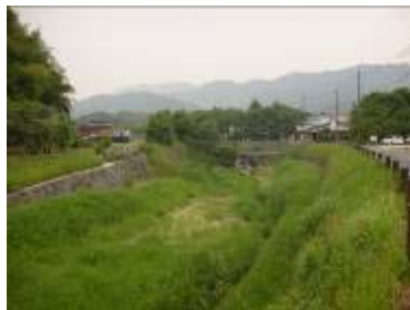
飛鳥川 の護岸整備
