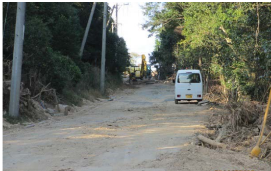
写真 32 土石流の痕跡 (写真 30 の右手方向道路沿い)
