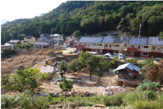
写真 30 木造 2 階建てアパートの正面全景 (正面奥および右手方向から土石流)
