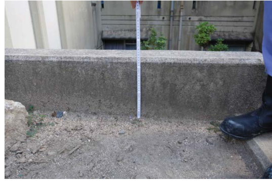
写真 12 RC 造壁高さ (無被害の別棟にて)
