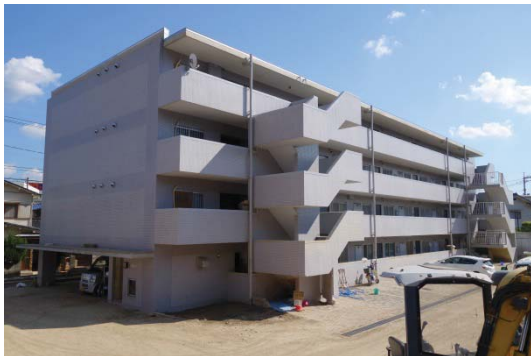
写真 28 民間共同住宅の全景
