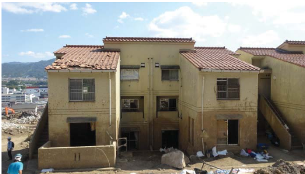
写真 17 9号棟の東側住戸
