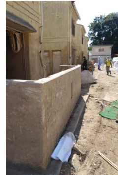
写真 18 9号棟山側の目隠し壁の状況
