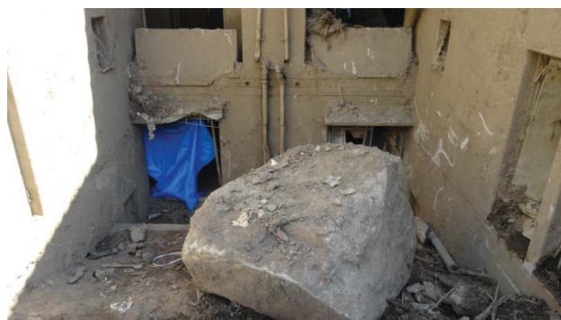
写真8 5号棟ドライエリア部
