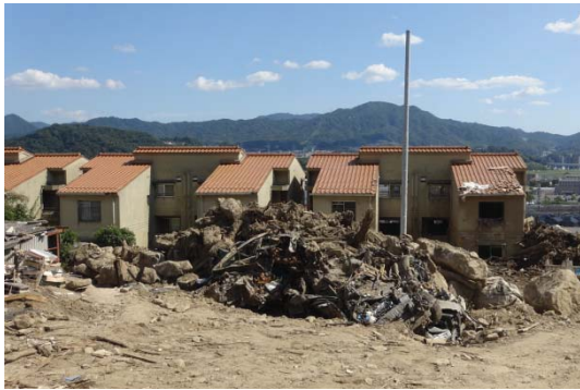
写真5 5号棟西側住戸全景
