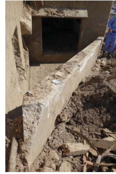
写真 16 道路側ドライエリアの擁壁
