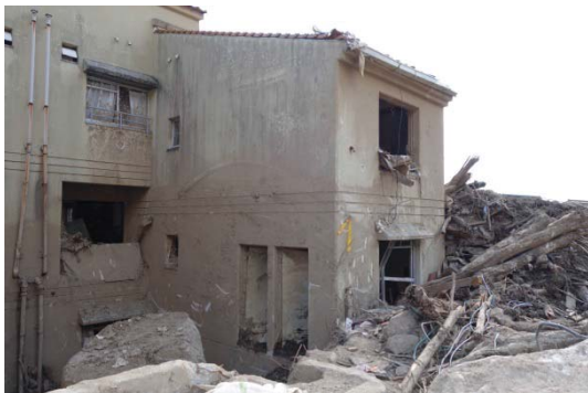
写真7 5号棟西端住戸の状況
