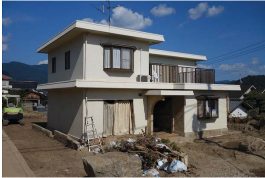
写真 26 コンクリートパネル造住宅
