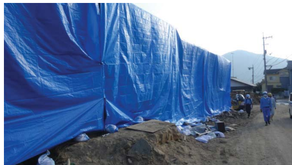
写真 33 木造 2 階建てアパートの山側
