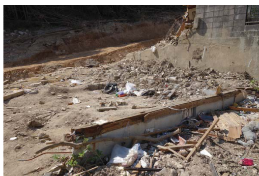
写真 25 上屋が流失した木造家屋の基礎
