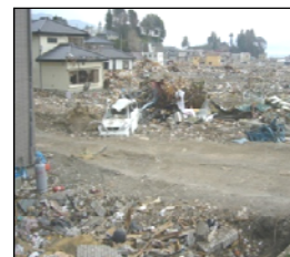
東日本大震災では、津波により境界情報が喪失
