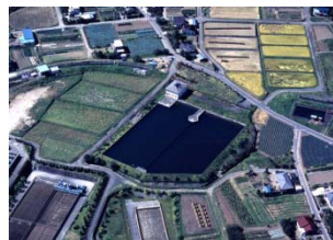
流況安定調整池
