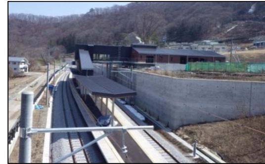
付替鉄道 (JR吾妻線,川原湯温泉駅(新駅)) (平成26年10月1日より営業開始予定)
