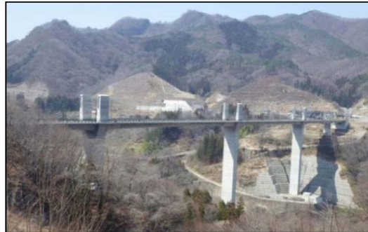
付替県道川原畑大戸線(湖面1号橋) (平成26年秋に供用開始予定)
