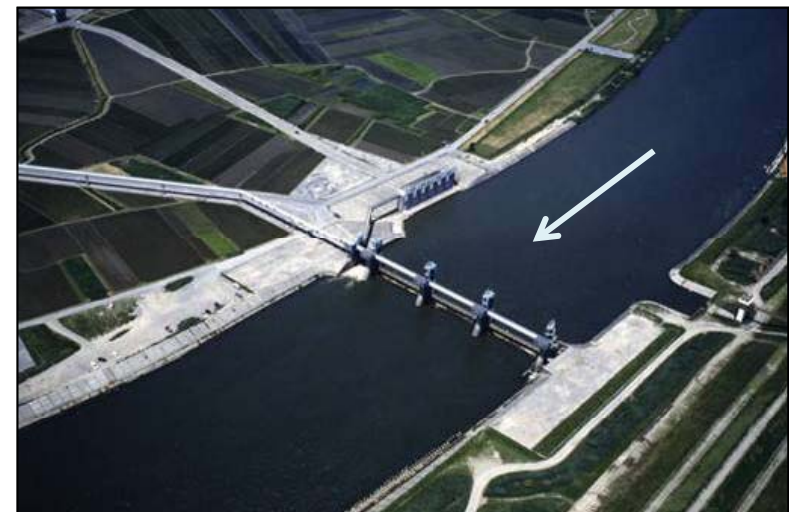
秋ヶ瀬取水堰全景
