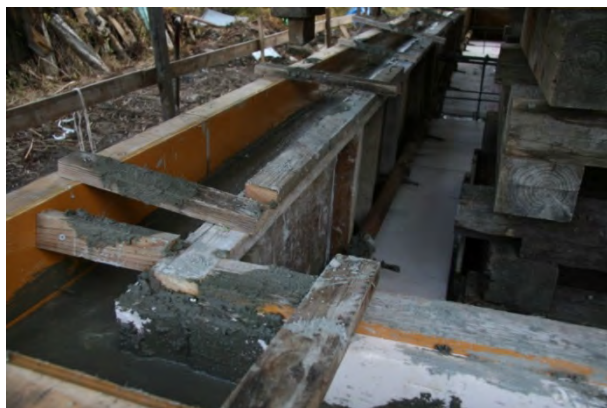
写真 31 基礎立ち上がりコンクリート打設
