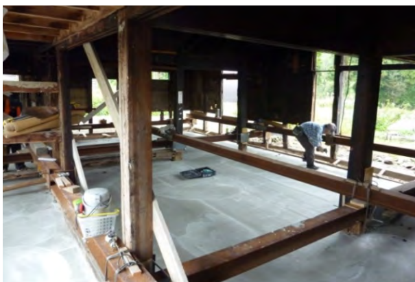
写真 28 ベタ基礎均しコンクリート施工
