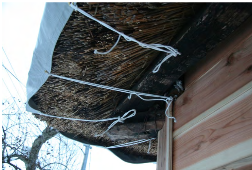
写真 18 落雪シートを設置するために軒下に設置した留め具
