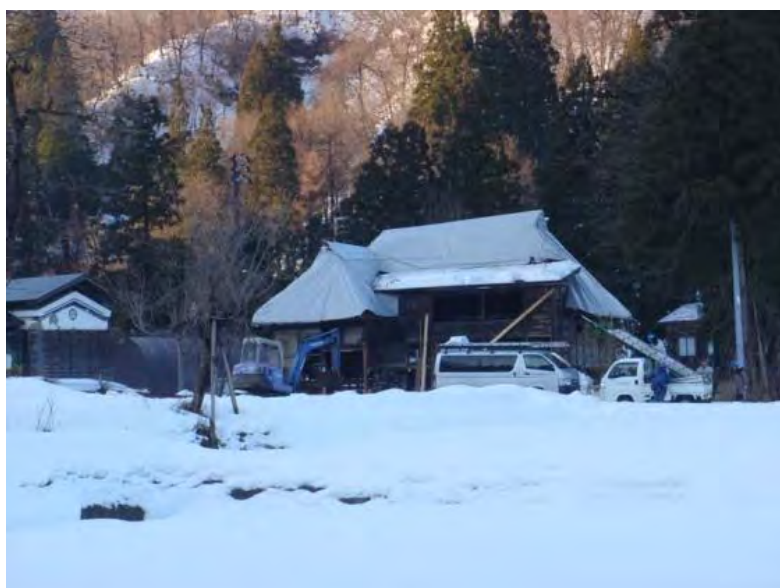
写真 22 落雪シートを設置した調査対象家屋
