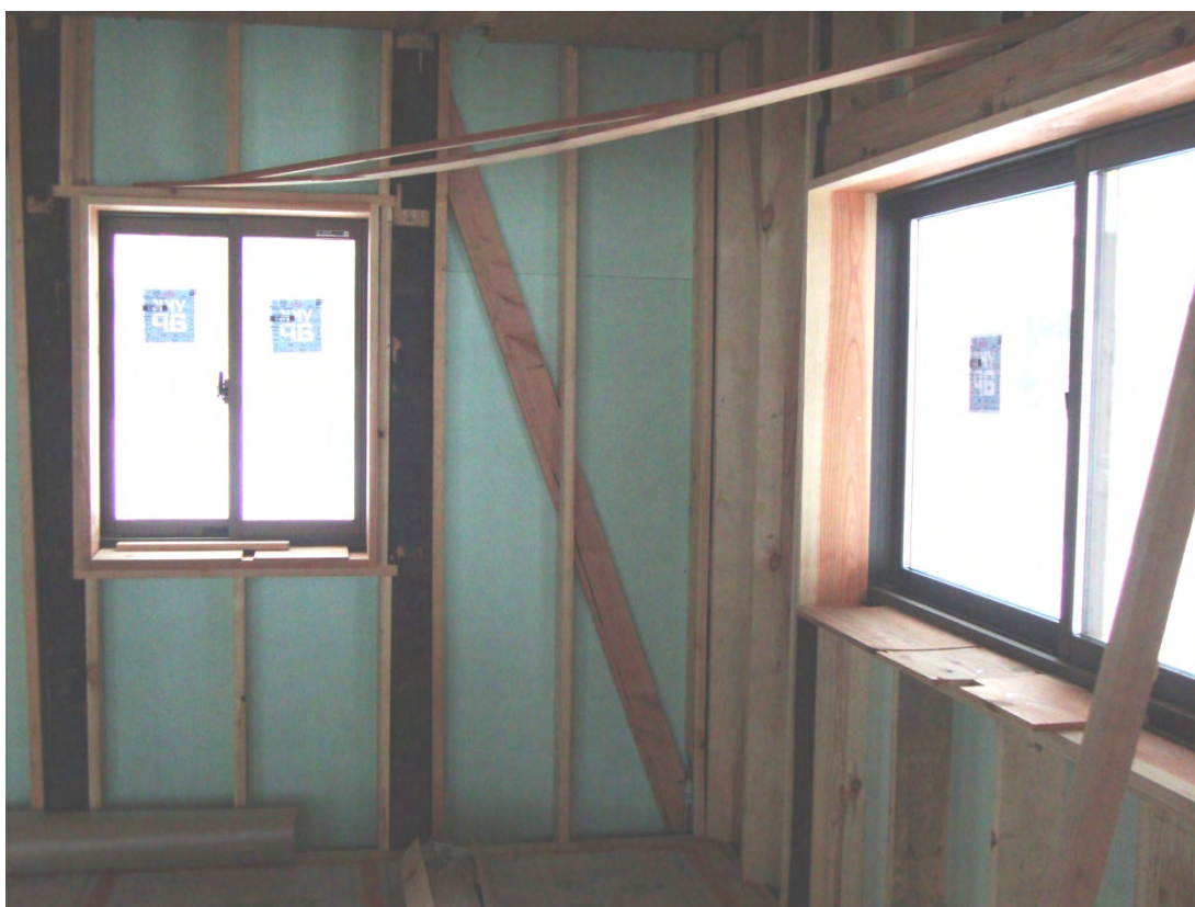
写真 49 窓枠を施した断熱サッシ
