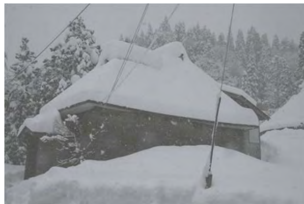
写真 44 湿雪時のトタン葺き屋根の様子
