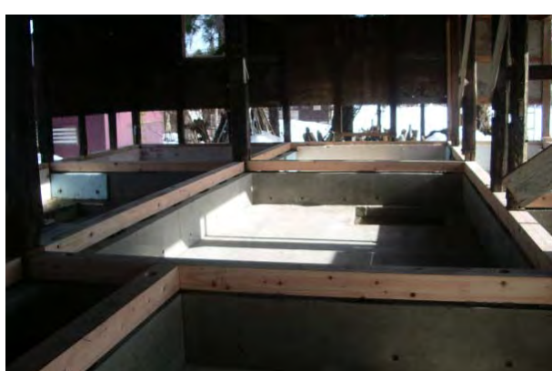
写真 33 土台施工
