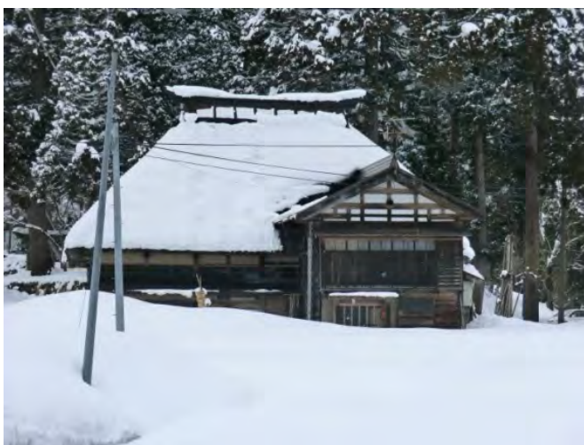
写真 7 茅葺き民家の屋根雪（石油ファンヒーター使用）
