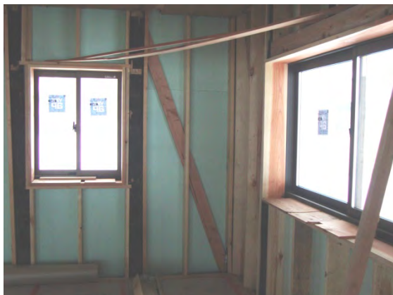
写真 34 外張り断熱の状況
