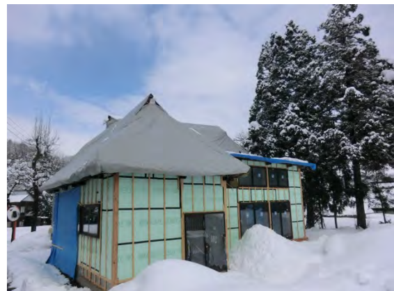
写真 34 外張り断熱の状況
