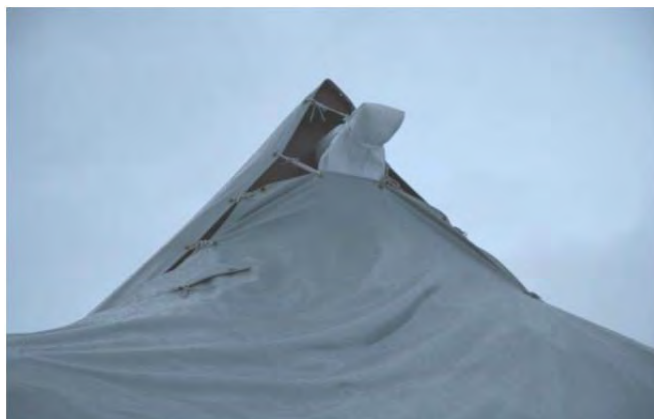
写真 21 落雪シートの笠木部分
