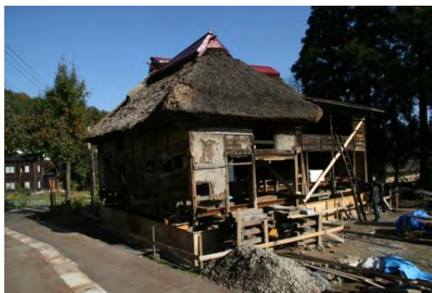
写真 29 曳家及び基礎型枠施工
