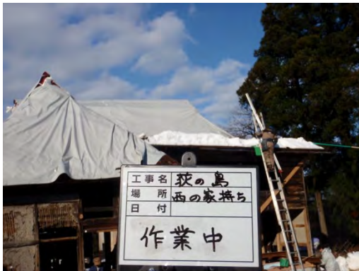
写真 23 落雪シート取付け作業
