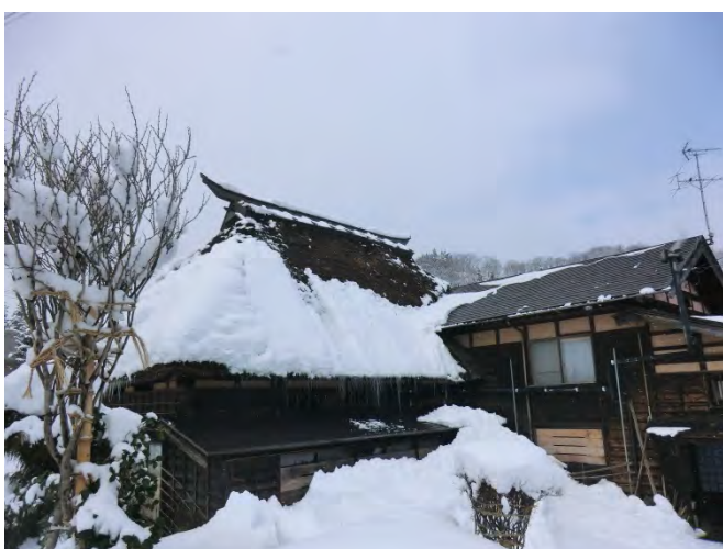
写真 8 茅葺き民家の屋根雪（薪ストーブ、石油ファンヒーター使用）
