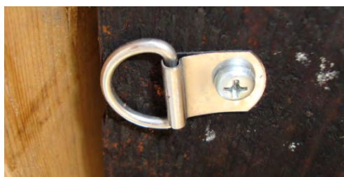
写真 18 落雪シートを設置するために軒下に設置した留め具
