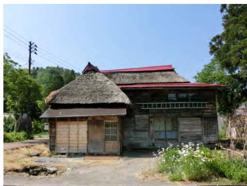
写真 26 対象家屋南側の施工前後の比較 (施工前)
