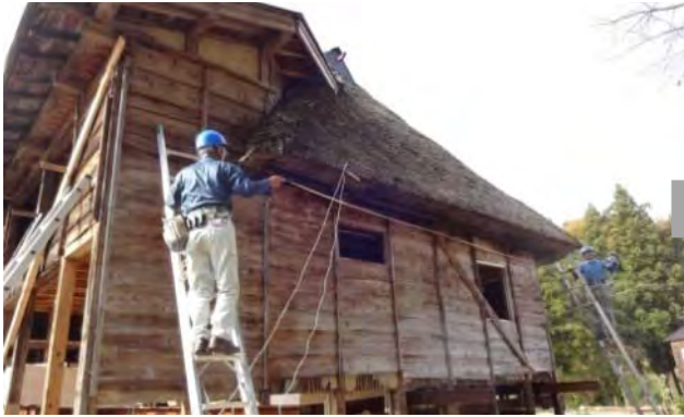
写真 27 対象家屋東側の施工前後の比較 (施工前)
