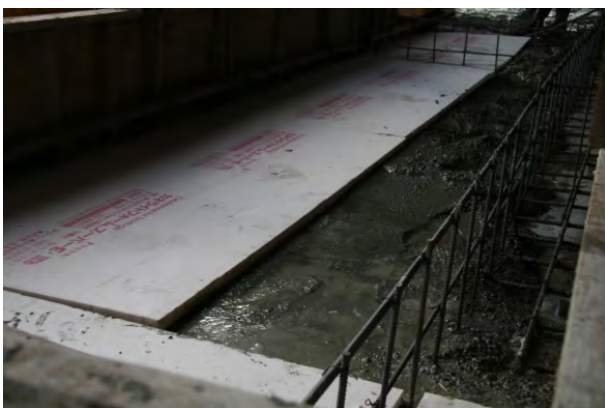
写真 32 基礎スカート断熱材施工
