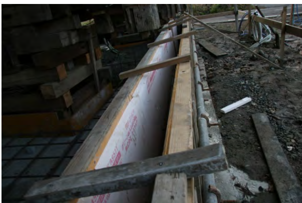
写真 30 基礎立ち上がり型枠・断熱材施工
