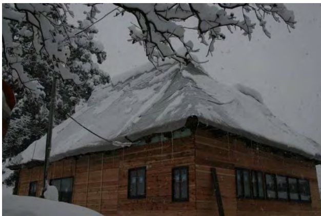
写真 42 湿雪時の落雪シート屋根の様子
