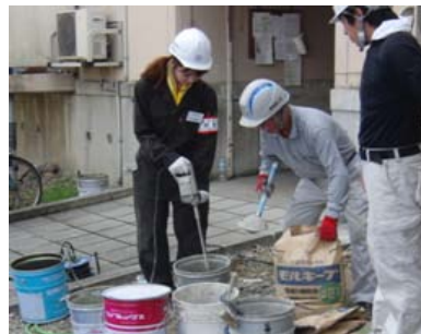
現場実習の様子(兵庫県建設業協会)
