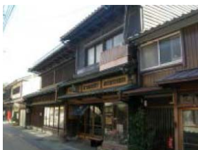
福嶋三弦店 (金沢市 / 市こまちなみ保存建造物)
