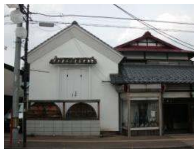
修理・修景後
