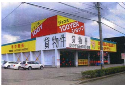
屋外広告物の撤去例
