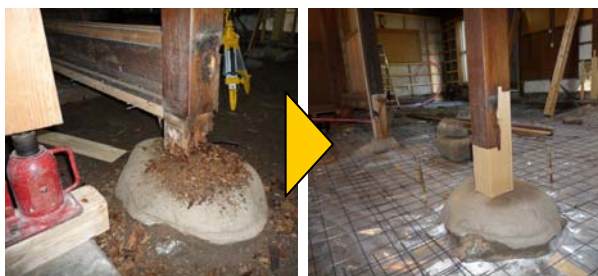
構造の修理の様子 （白蟻被害のあった柱を根継修理）
