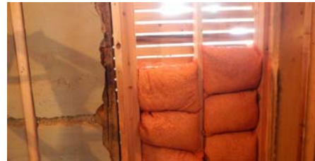
木摺り工法による土蔵の修理
