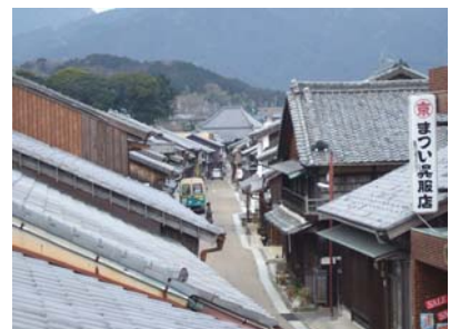
■重要伝統的建造物群保存地区 関宿 (亀山市)
