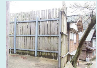
鉄骨と板で作られた間垣
