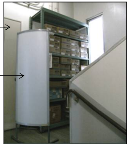
写真8 階段室の防火戸
