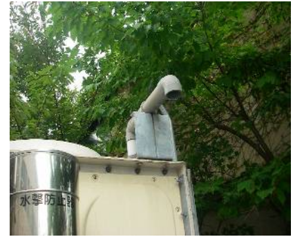
写真5 受水タンク上部
