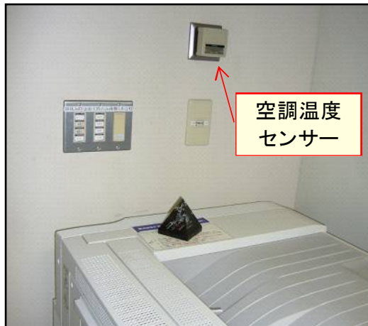
写真4 空調温度センサー周辺
