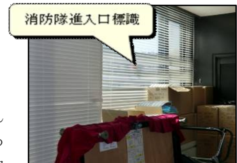
写真7 消防隊進入口周辺
