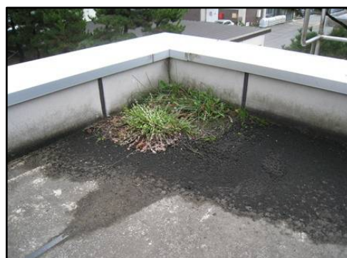
写真1 屋上排水口付近
