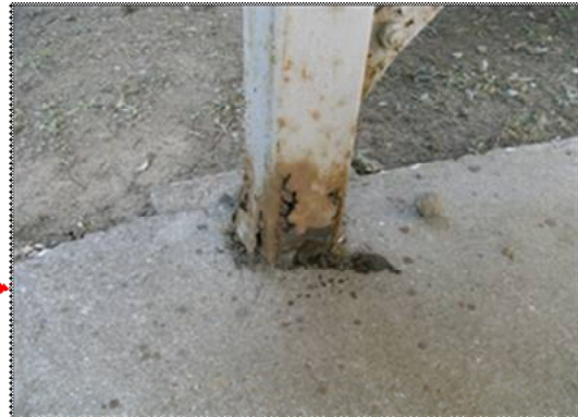
写真10 柱の接地部
