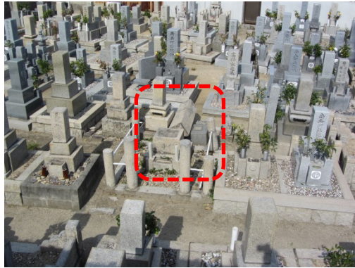
写真 5.9 墓石の転倒（ごく一部）
