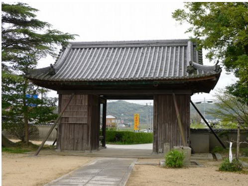
写真 6.32 鋼材により耐震補強された門 (大きな被害は見られない)
