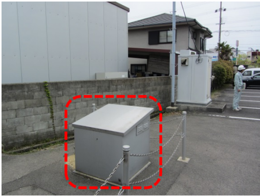
写真 6.13 地震計（震度 6 弱、淡路市志筑 しづき ）ブロック塀や民家に特に被害なし
