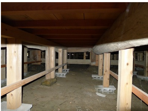
写真 6.34 本堂床下 (石場建ての柱と束)
