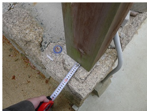
写真 6.17 移動した縁束（本堂）
