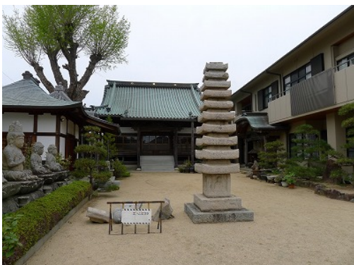
写真 6.16 崩壊した石塔（県指定文化財）
