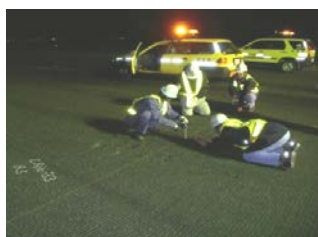
(基本施設点検実施状況)
