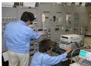
(航空保安施設点検実施状況)
