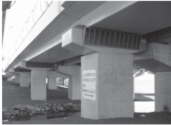
<橋梁の耐震補強>
