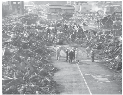
<東日本大震災における道路啓開>
