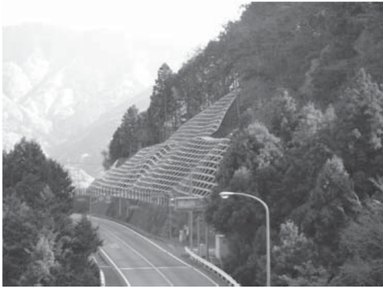
<斜面崩落防止対策>
