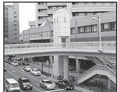
<エレベーターの設置>
