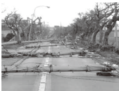
<電柱の倒壊による道路閉塞>
