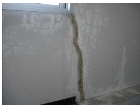
〔外壁クラックから室内への漏水が発生しており、外壁改修が必要〕
