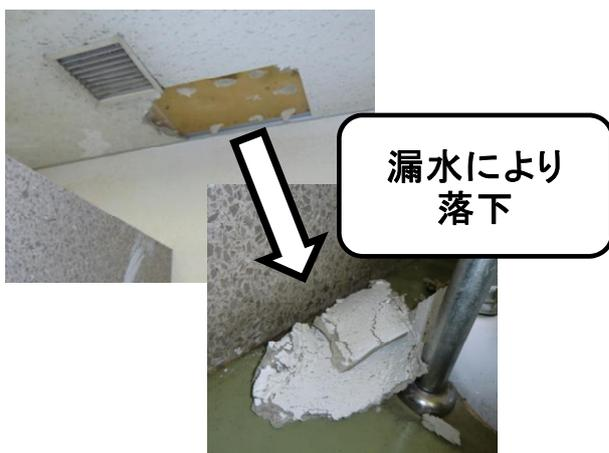
〔天井内配管からの漏水により天井落下が生じており、配管改修が必要〕
