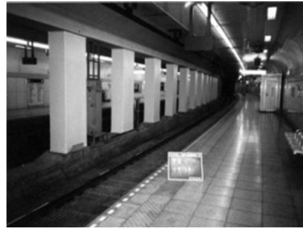
【地下鉄駅の中柱の補強】
