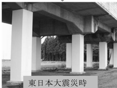
【高架橋の補強】
