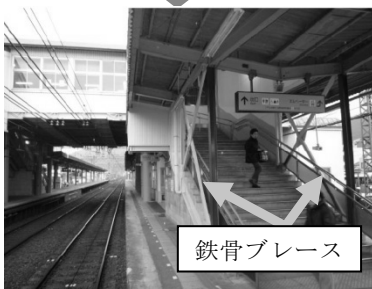
【橋上駅の補強】
