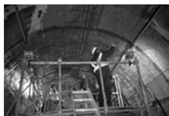
繊維シート貼付
