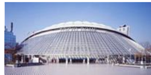
出典：株式会社東京ドームHPより
