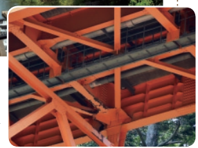
交付金適用対象となっている湯の華燦々橋。集落をつなぐ生活の橋として利用されている。橋脚の腐食のほか、床版の損傷などが見られる。
