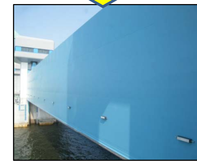
樹脂系の塗装材料を使用
