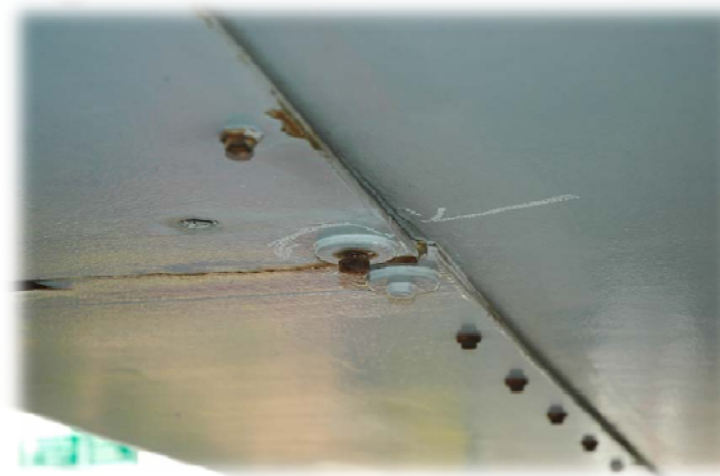
化粧版取り付け状況
