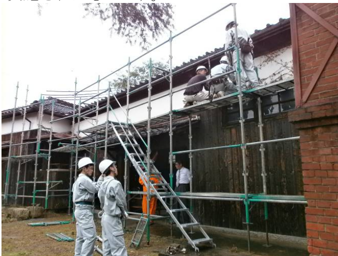
・工事の様子
