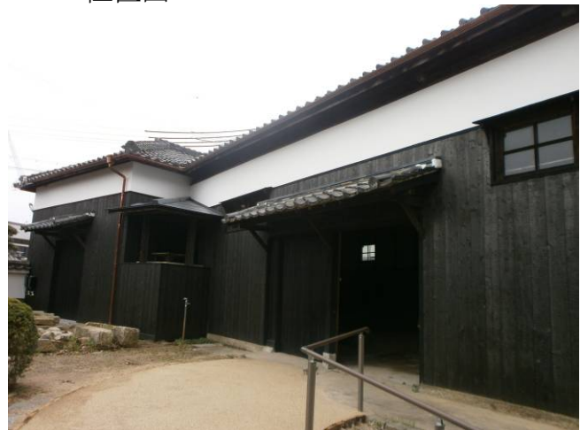
・完成した外観
