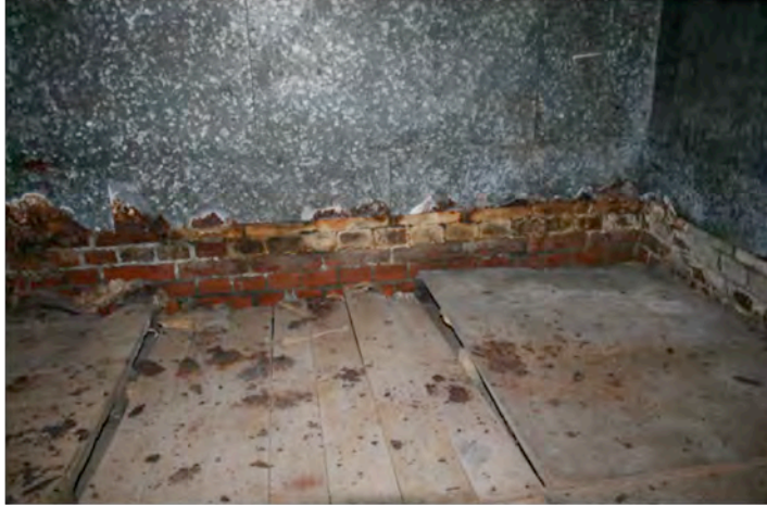
写真29 中央卸売市場倉庫 基礎部分+内壁
