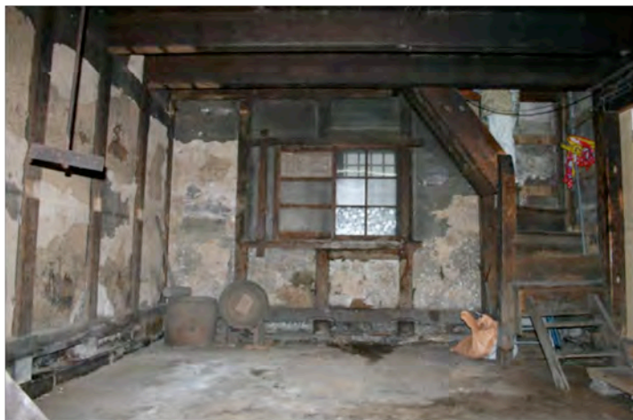
写真46 越後屋家具店石蔵 1階内観
