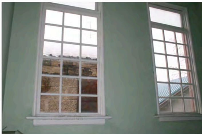
写真52 旧花園病院 窓台付嵌め殺し窓
