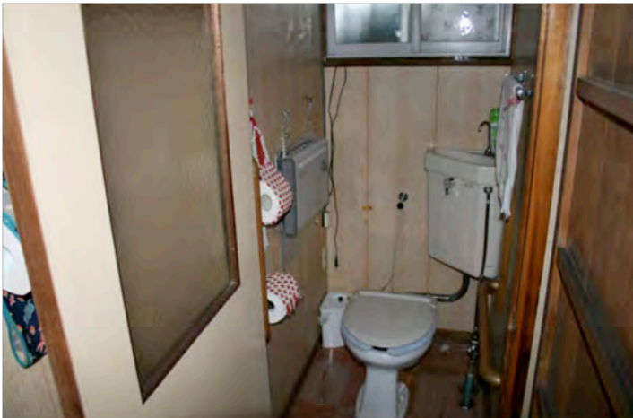
写真32 旧村上邸 1階トイレ
