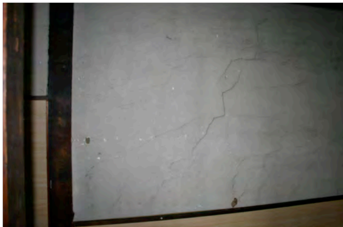
写真22 山田貸家 2階廊下内壁
