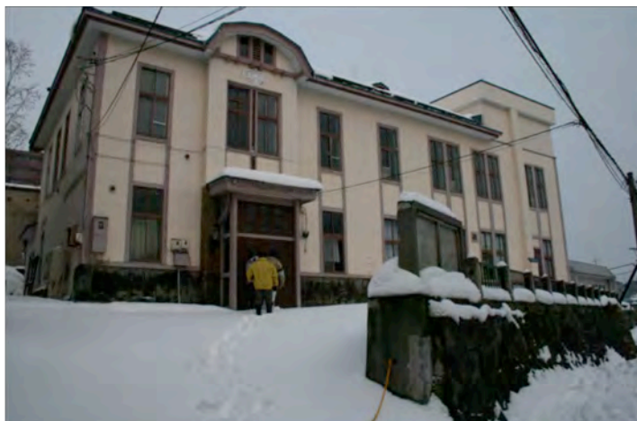
写真49 旧花園病院 正面全景
