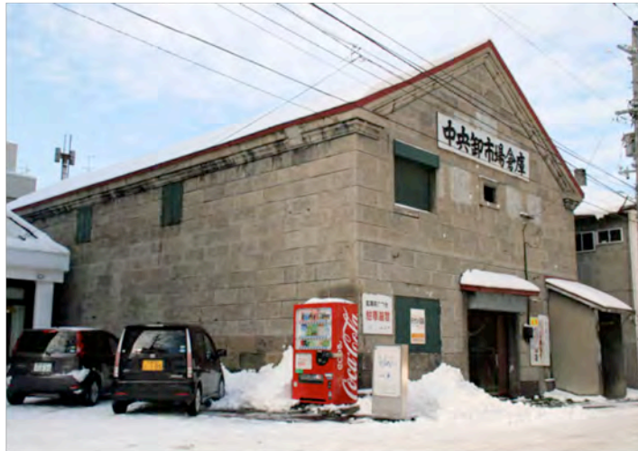
写真25 中央卸売市場倉庫 建物全景
