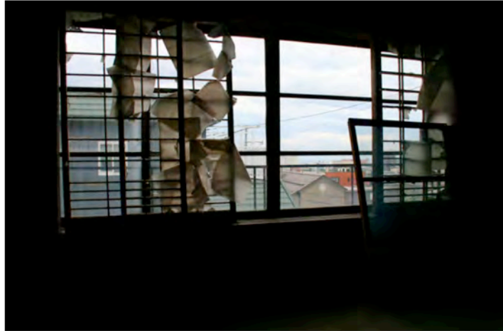
写真39 旧渡辺邸 洋館2階開口部
