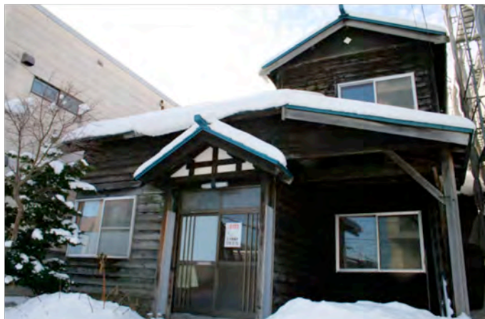
写真19 山田貸家 正面全景
