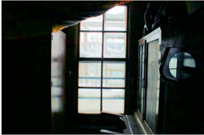
写真33 旧村上邸 2階上げ下げ窓 趣はあるが如何せん防寒上宜しくない。 やはり内部に樹脂サッシを取り付け快適性を付加することにより、 内部結露防止、断熱効果は発揮。 この部屋の内部には開口部以外は歴史性は無いので大丈夫である。
