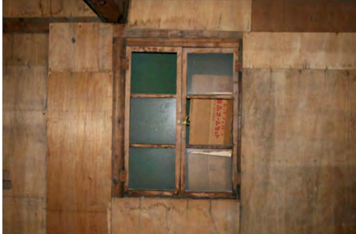
写真27 中央卸売市場倉庫 2階開口部
