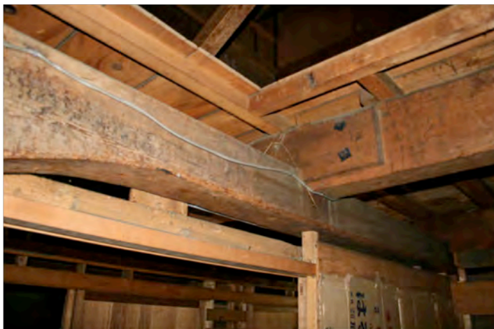
写真30 中央卸売市場倉庫 小屋組
