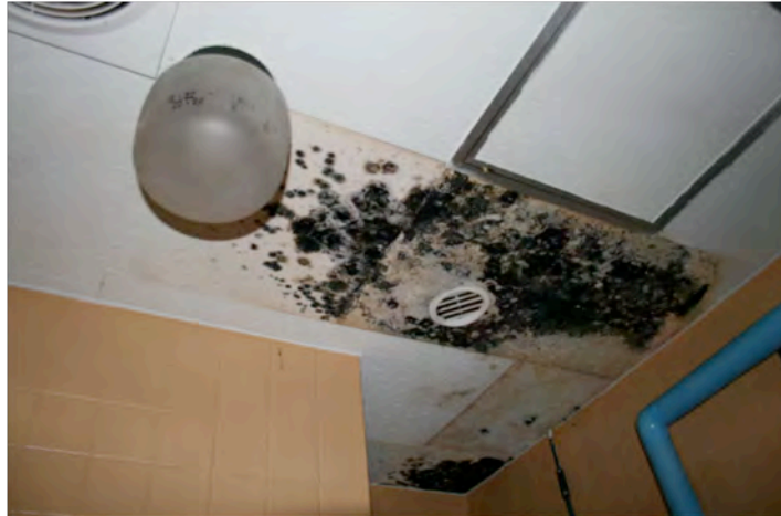
写真53 旧花園病院 2階トイレ天井部分 2階トイレ天井部分に一部カビが発生している。 ここは以前にリフォームした時に天井はジプトンであるので 原因を追及し天井は張り替える。 所見では換気扇の廻りの配管漏れと思われるので換気扇を外し 配管のチェックをして修復する。
