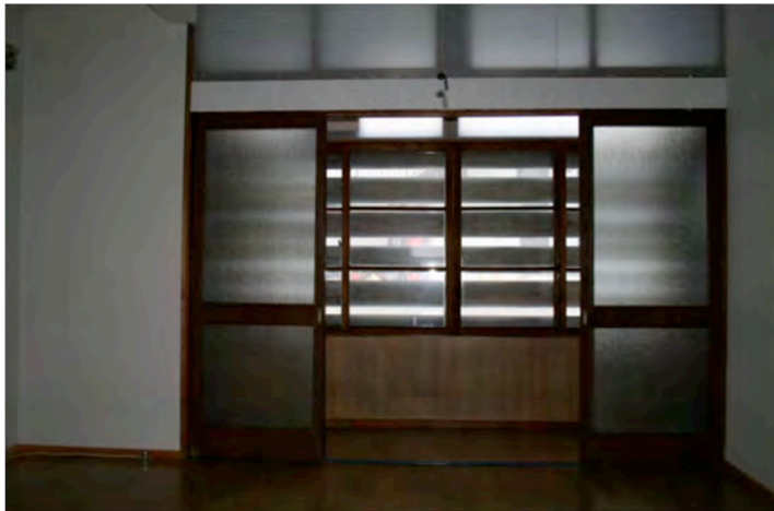
写真24 山田貸家 1階縁側
