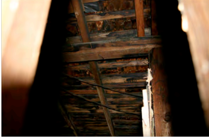
写真23 山田貸家 小屋裏部分
