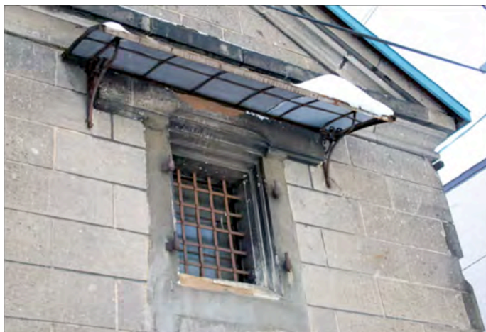
写真43 越後屋家具店石蔵 正面開口部
