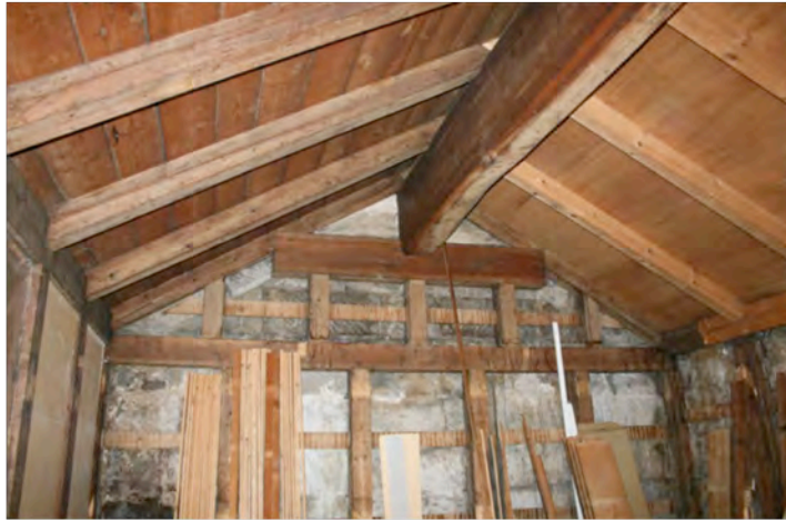
写真45 越後屋家具店石蔵 石蔵小屋組
